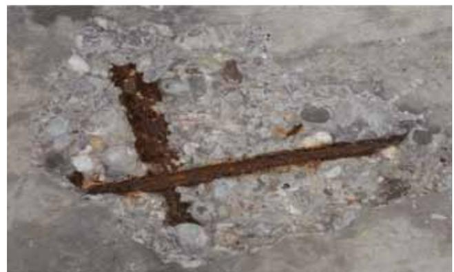
Abb. 5: Schäden an der Armierung
